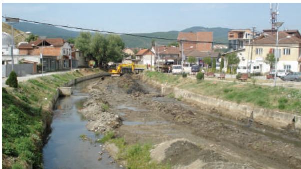
➤ Shtrati i lumit në Shtime, para dhe pas intervenimit
