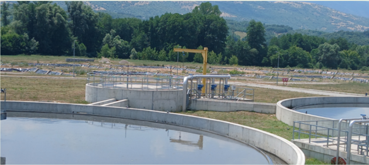
Foto - Impianti në Gjakovë dhe Prizren
